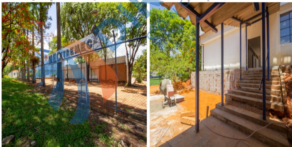
Figura 4 e 5: Registro fotográfico obras revitalização Cetremec
